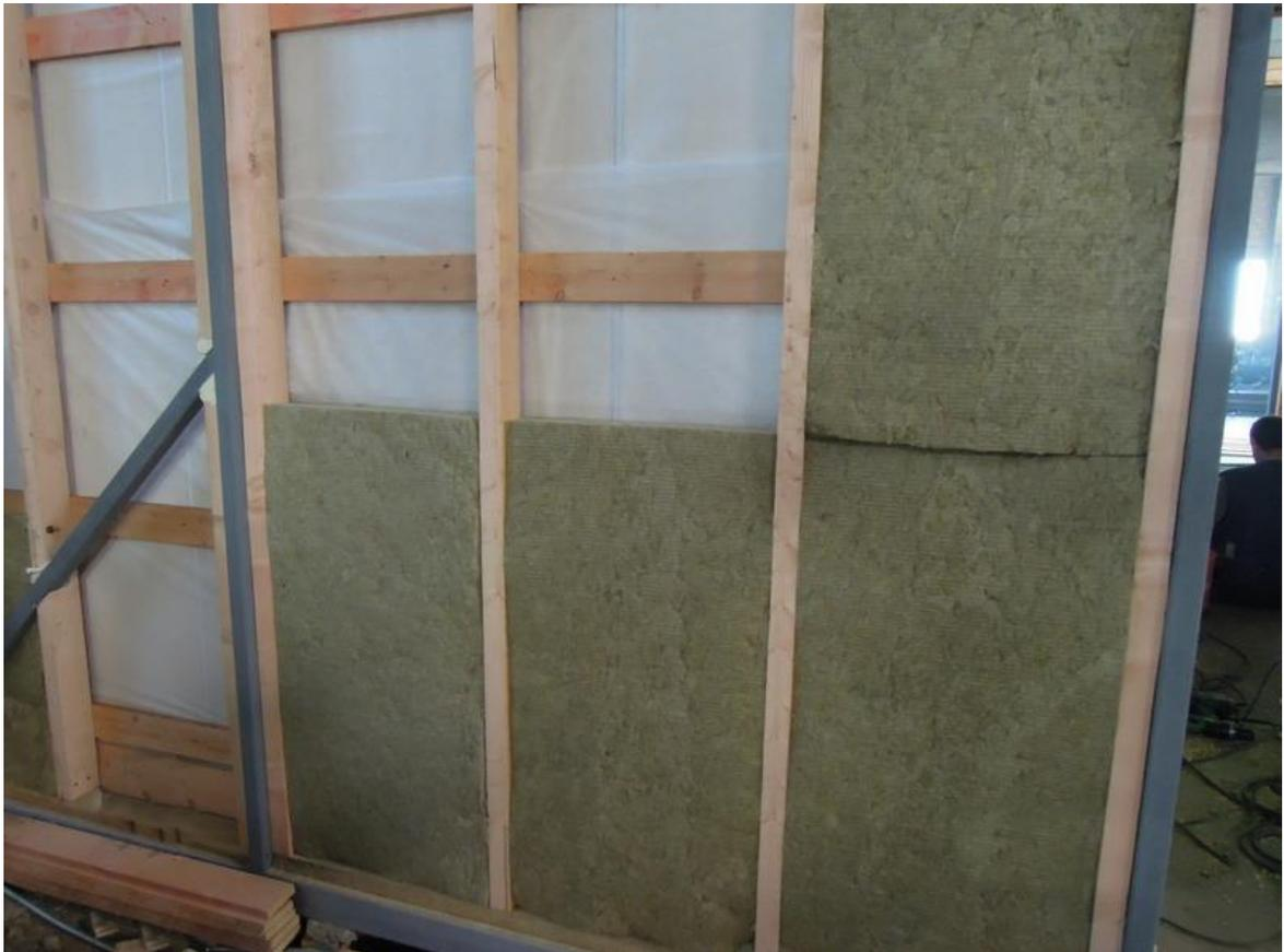
Рис.5 Утепление стен, деревянные элементы антисептированы
