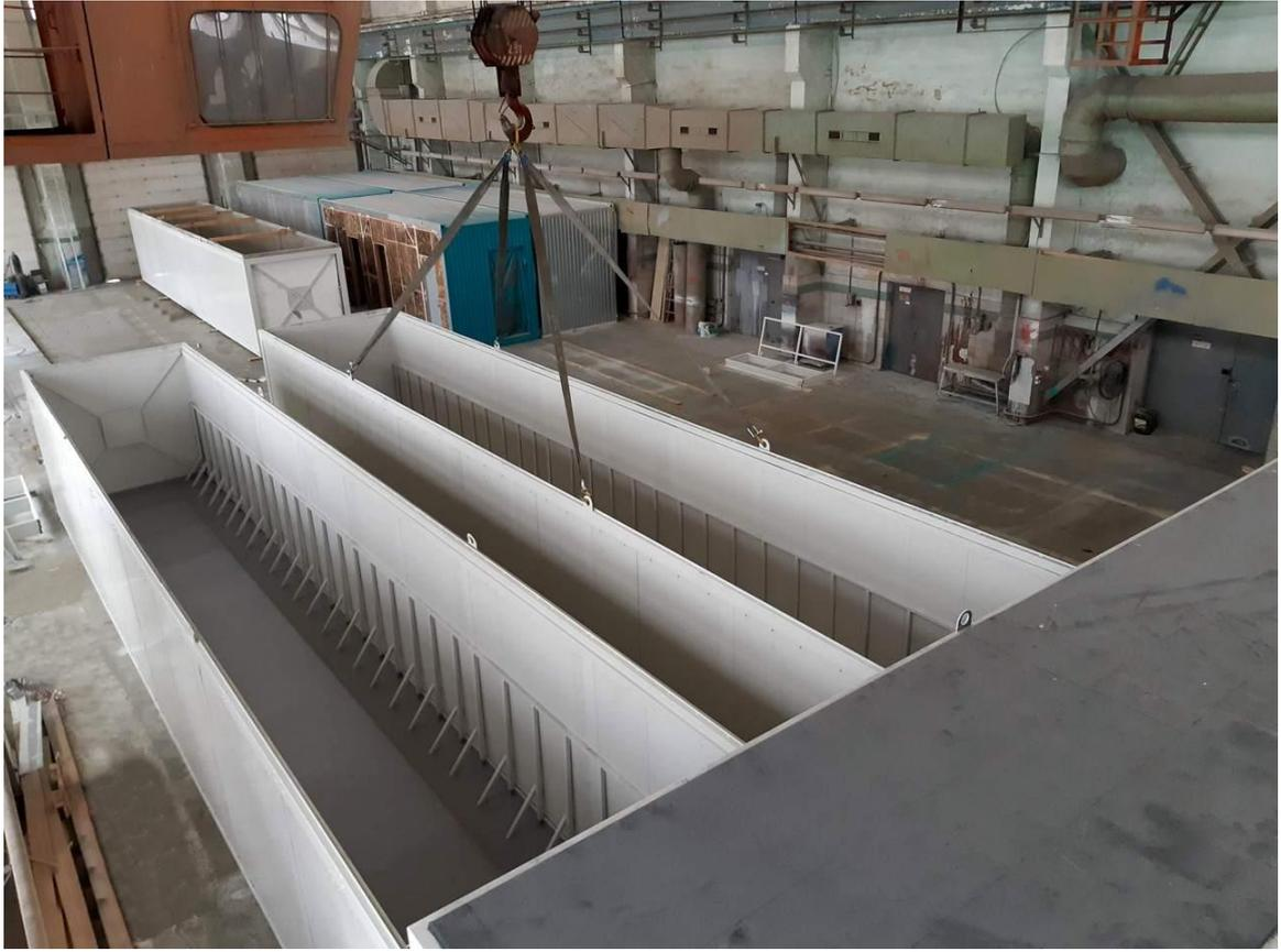
Рис.8. Пробная сборка модульного здания под размещение оборудования водоочистки из 14-ти метровых контейнеров
