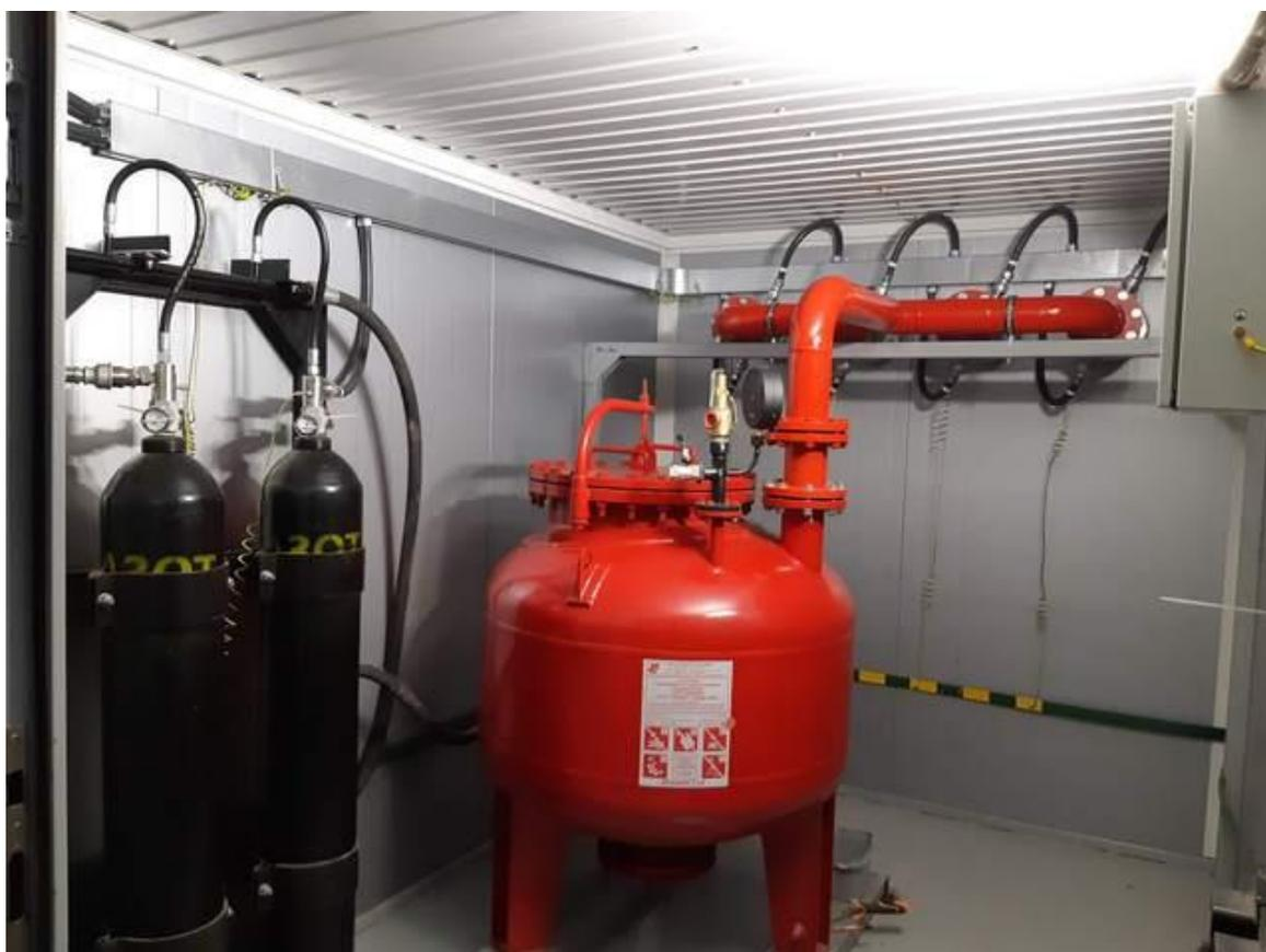
Рис.7 Исполнение контейнера на заказ под модуль пожаротушения
